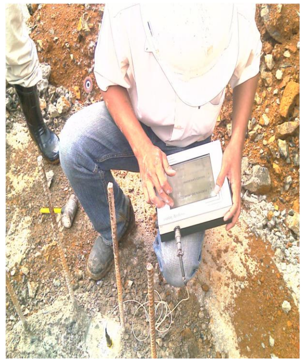
Thử cọc bằng phương pháp PIT
